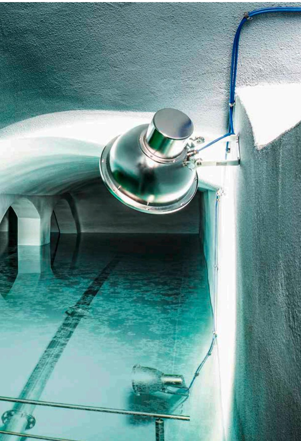
**Mit mineralischem Spritzmörtel beschichtet: Die Trinkwasserhochbehälter der Stadtwerke Meiningen**
